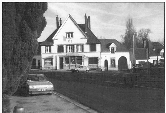
Après la mise sous terre
