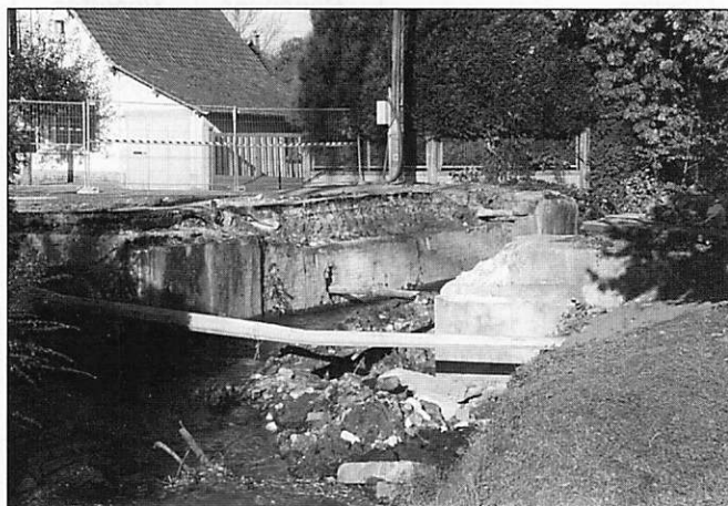
Le pont Pierru pendant les travaux
