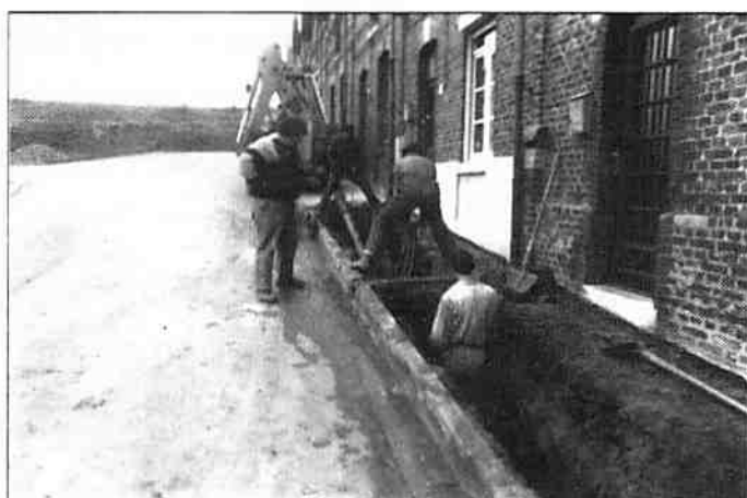
Renforcement d'adduction d'eau potable "Cité Saint"
