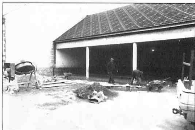
Début travaux : Aménagement du préau
